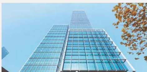
Многоэтажное здание без стилобата
